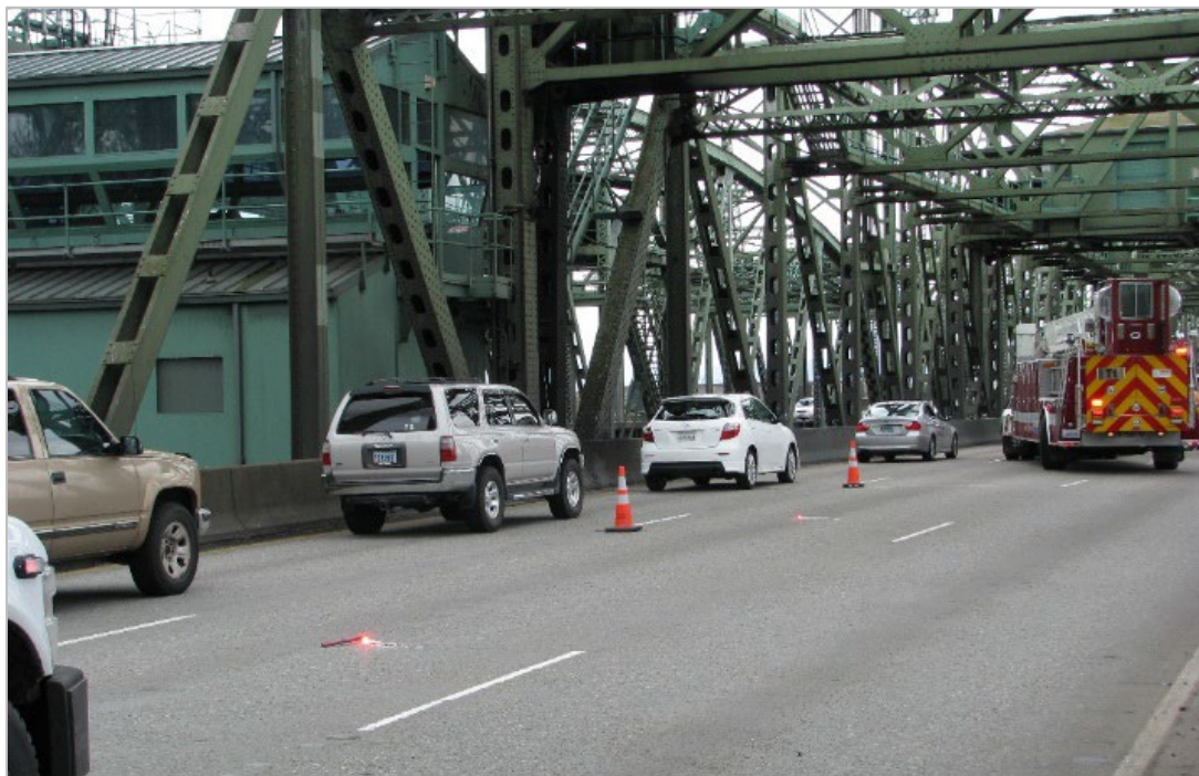
Рисунок 2. Авария, блокирующая Межштатный мост
